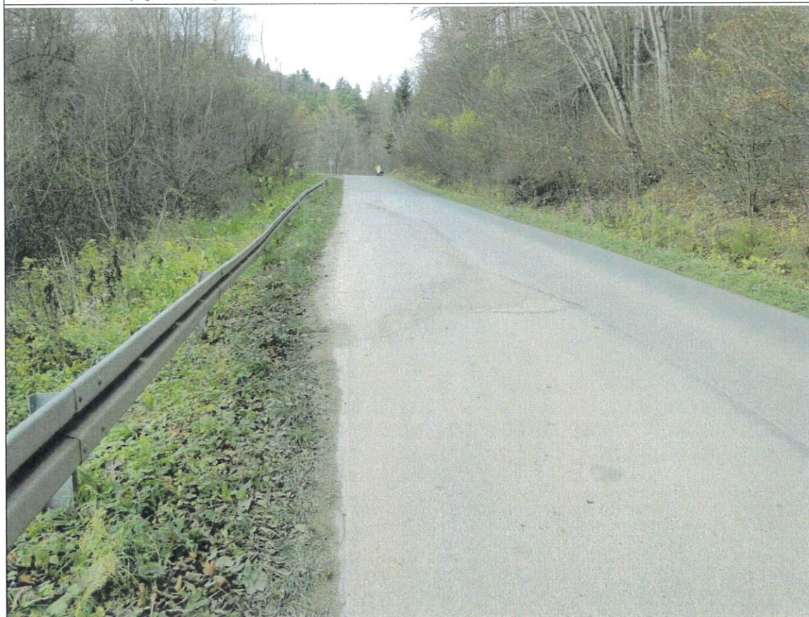
Widok na naprawiony fragment jezdni który zlokalizowany jest na obniżeniu korpusu drogi
